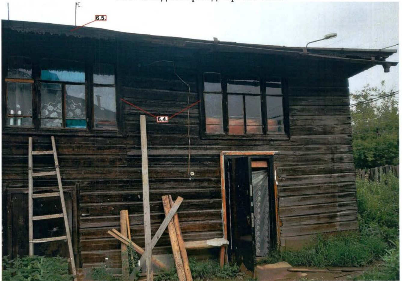
Юго-западный фасад. Правая часть
