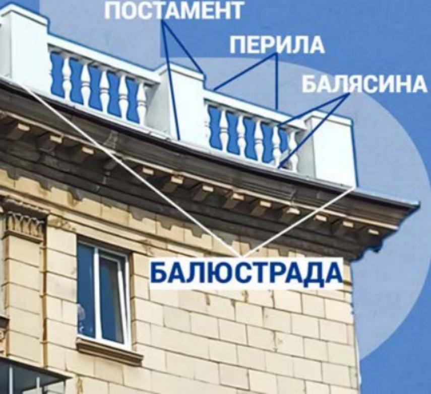
Применяется в ограждении лестниц, террас, балконов, крыш или в качестве декоративного элемента на фасаде здания.
