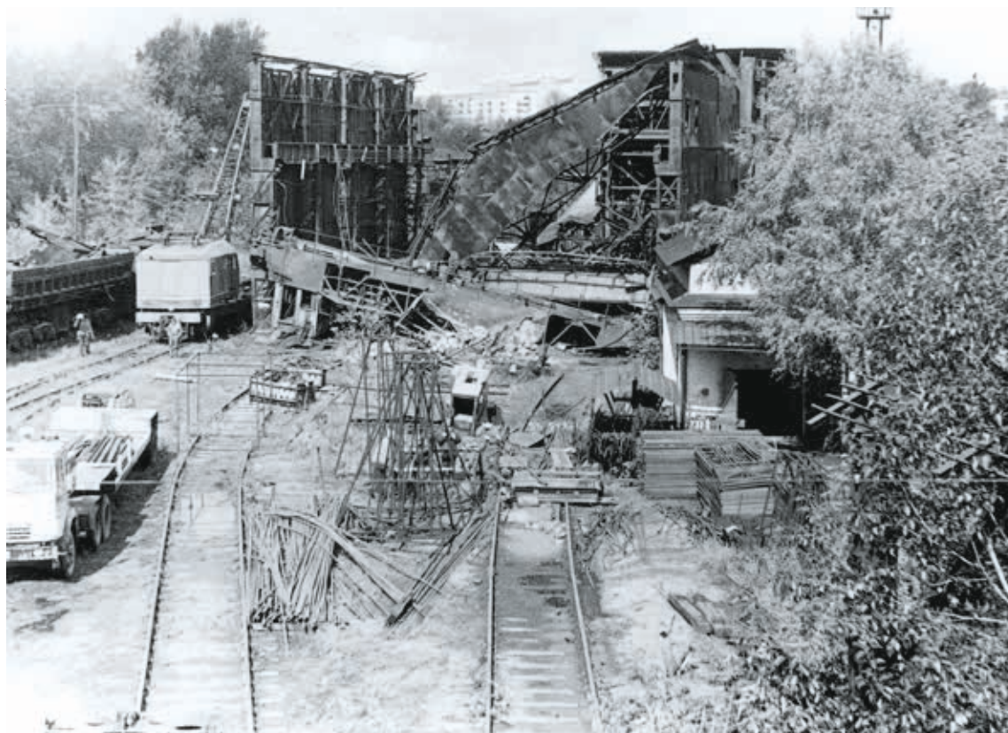
Процесс демонтажа металлических конструкций на территории завода-музея (Старого Демидовского завода). Нижний Тагил, 1990-е гг.
