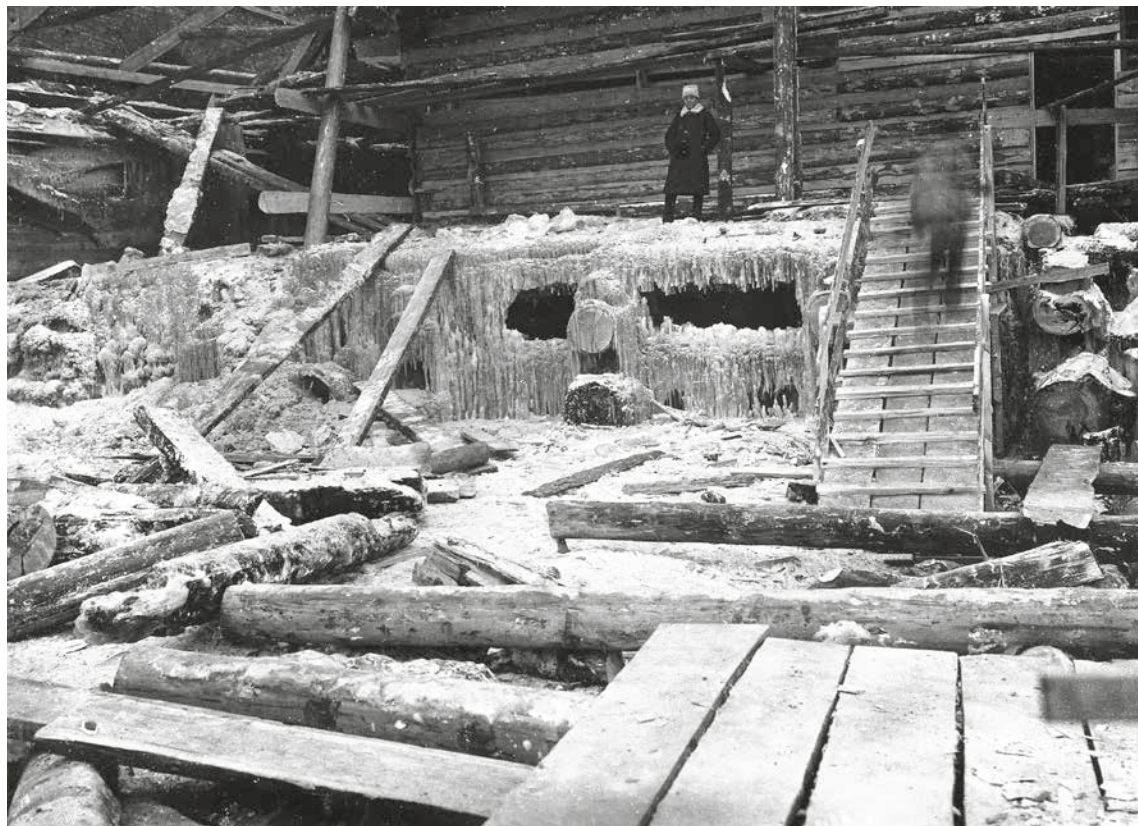
Обледенение лиственничных ряжей плотины Старого Демидовского завода в Нижнем Тагиле. Ноябрь, 1927 г.
