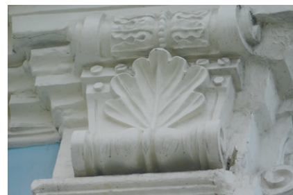
Ил. 2. Кронштейн венчающего карниза. Дом Уткина
