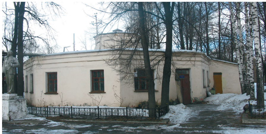
Ил. 1. Здание гайки. Фото 2017 г.
