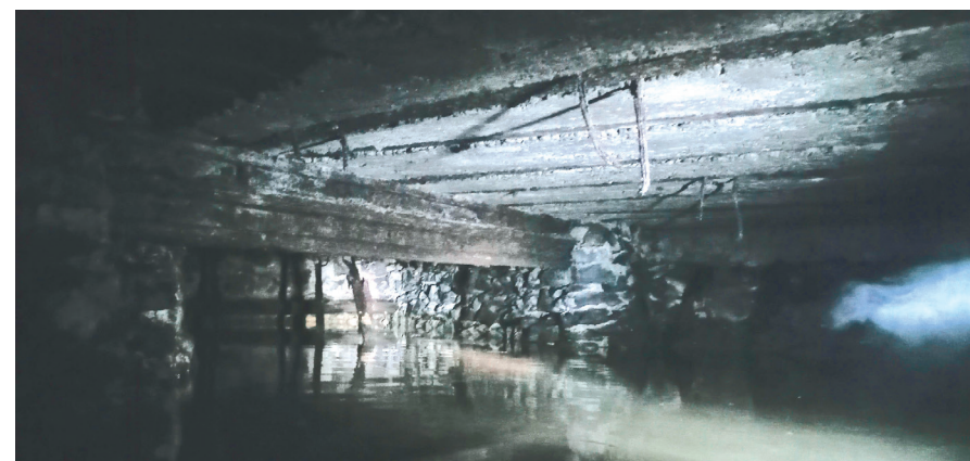
Ил. 6. Вновь выявленный подземный канал. Фото Ю.М. Баранова. 2020 г.
