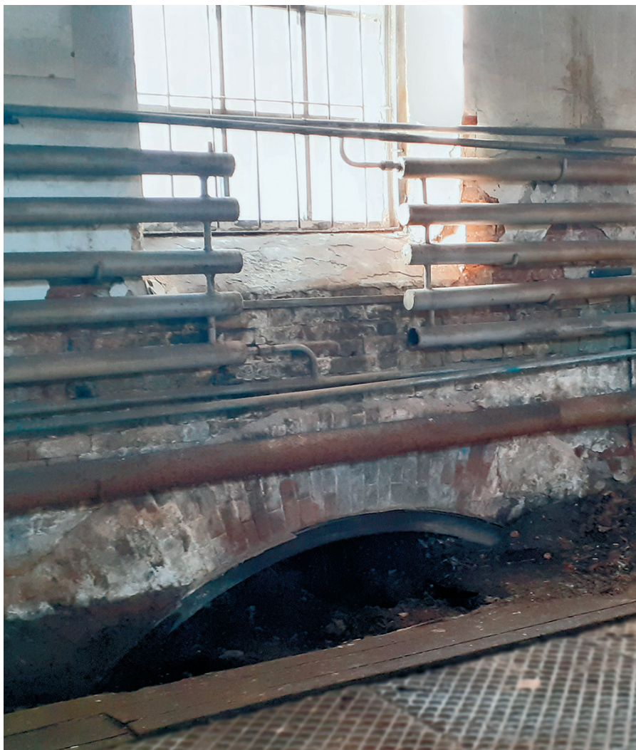
Ил. 4. Подземный сливной канал механической фабрики. Фото Ю.М. Баранова. 2020 г.
